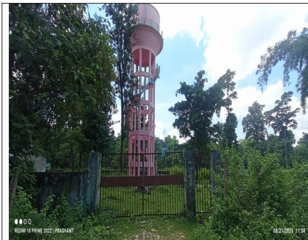
7. OHT premises Gate
