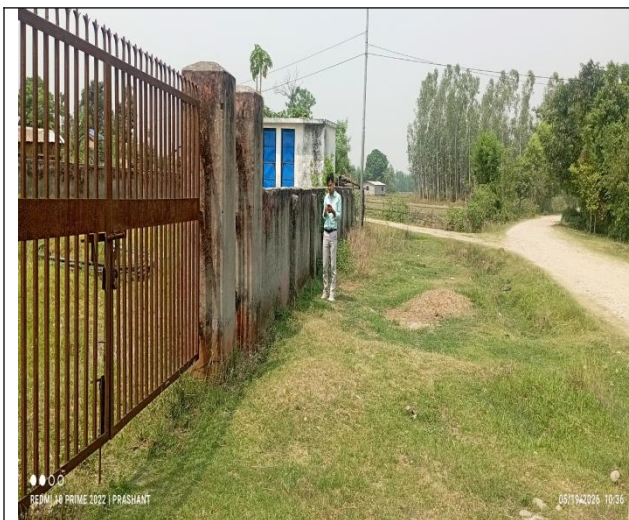
4. OHT premises Gate
